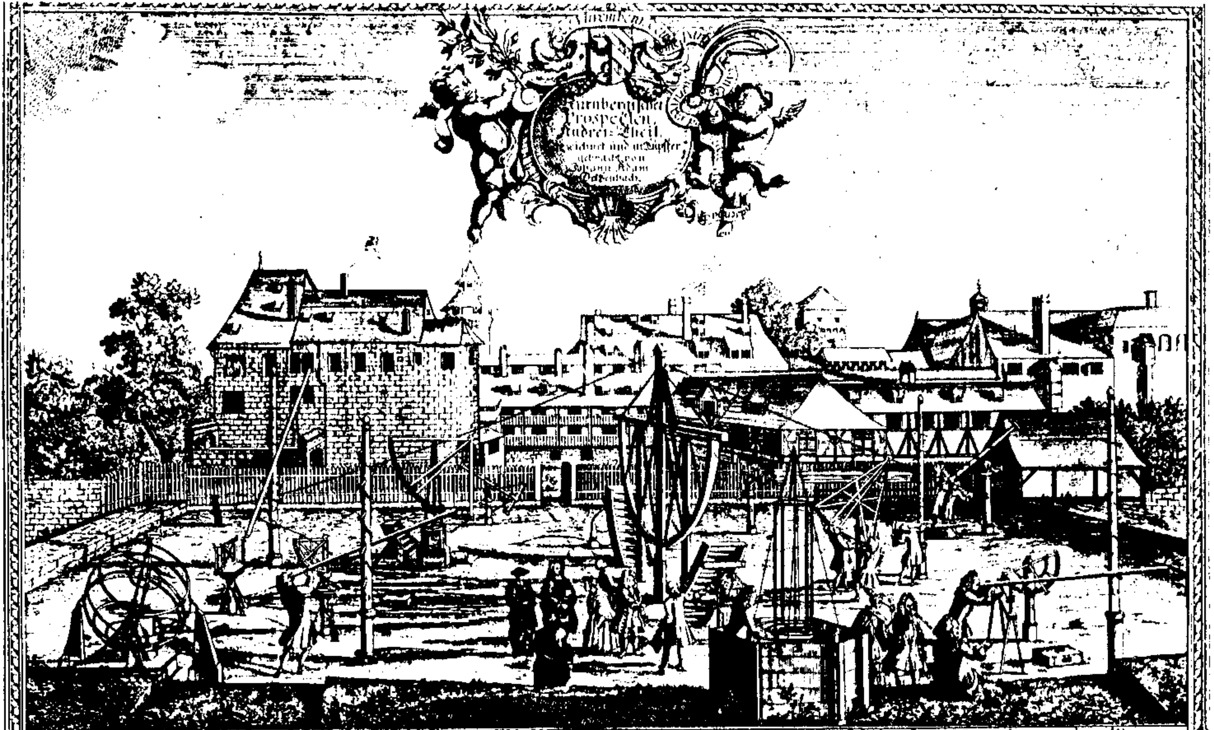
Das Nurnberg Observatorium, Astronom wie es von dem Herr H. C. Eimmart berühmten Mathem. aufgerichtet worden. A. Stabenealischer eilerner Trient mit Messing ubergehen von 10 Schüen B. Annulus Azimuthalis von 8 sch. C. hemisphäischer Quadrant von Messing. von 8 sch. D. ein kleiner von 4 sch. E. Goniometer ummessen von 8 sch. F. Sextant von Messing von 8 sch. G. Observatorium C. andere Art von 8 sch. H. einem Observ. H. einem Hemisphärisch von 8 sch. I. Radius auf 3 Grad von 8 sch. K. andere auf 10 Grad von 8 sch. L. einem Sphärisch armillaris von 8 sch. im Diam. M. Sphärisch armillaris von 8 sch. N. Mechanische Machung Helioscopia Observ. polhem. Sphärisch von 8 sch. O. einem Pflanzstein von 8 sch. P. einem Pendel von 8 sch.
